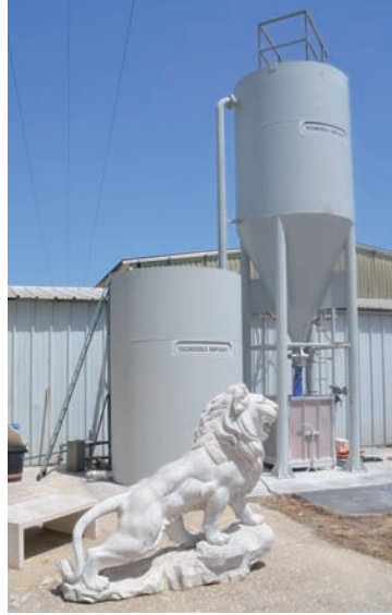
Les espaces extérieurs de la marbrerie avec un imposant système de traitement des eaux de l'atelier, Tecnoidea Impianti.
